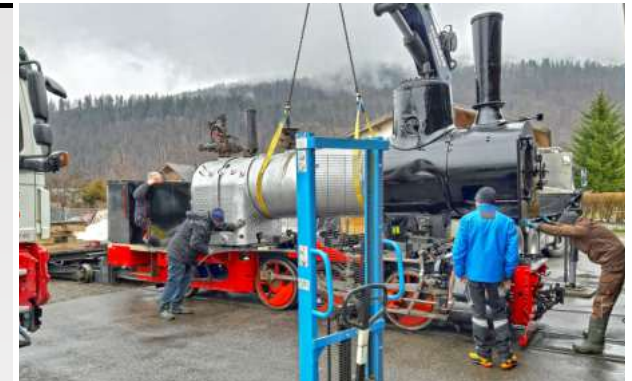
März 2021 – Einbau Kessel
