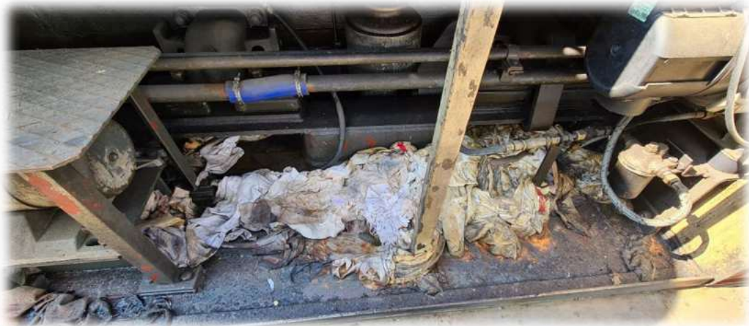
Bild 5: Zustand im Maschinenraum vor Beginn der Arbeiten. (Foto: Ing. Stefan Rottensteiner)
